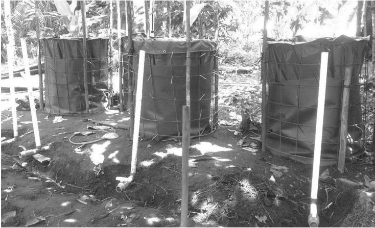
Gambar 22. Perakitan kolam bundar diameter 1 m di Air Gantang, Parittiga, Kab.Bangka Barat (atas dan tengah) dan di Parit Padang, Sungailiat, kabupaten Bangka
