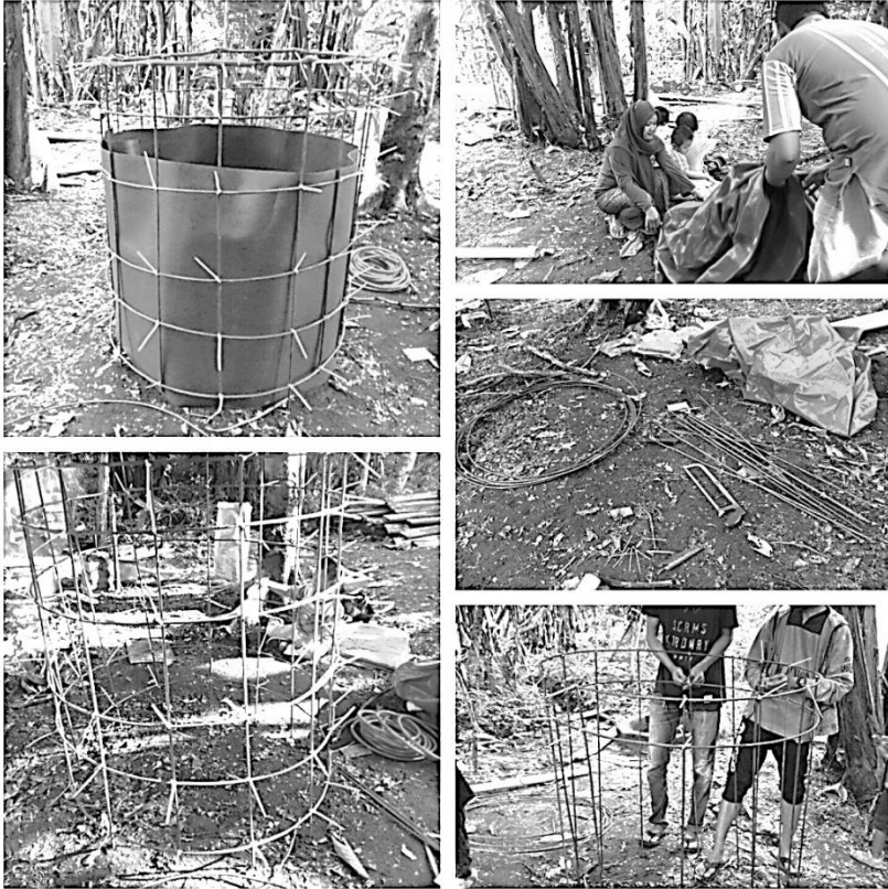
Gambar 17. Perakitan kerangka dan pemasangan terpal kolam bundar di Parit Padang Sungailiat.
