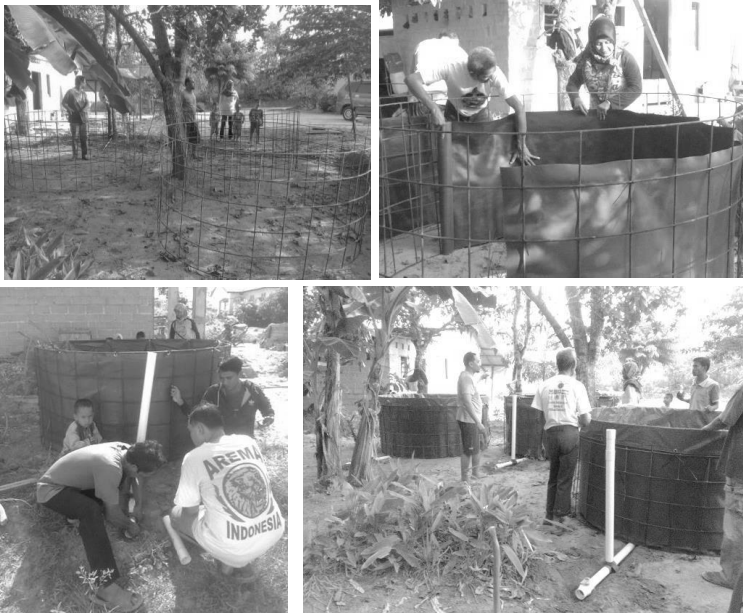
Gambar 21. Perakitan kolam terpal di kelompok Air Samak, Muntok, Kabupaten Bangka Barat.
